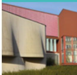
Bibliothèque Universitaire , Le Mans. BEAUDOUIN Architectes
