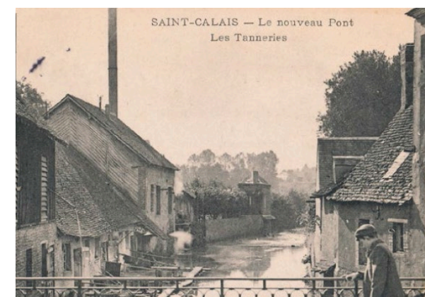
Vue des tanneries depuis le pont Gautray (1906)
